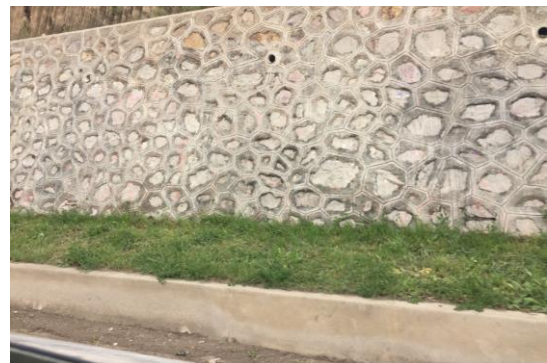
六棱混凝土预制空心块+植草护坡
