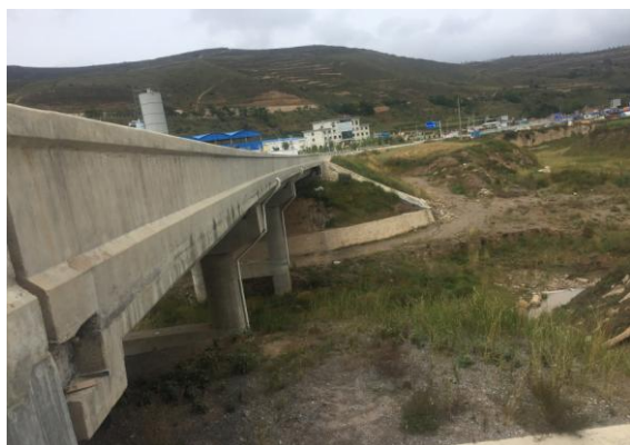
跨河桥梁两侧采取设防撞栏，设置事故废水排放系统
