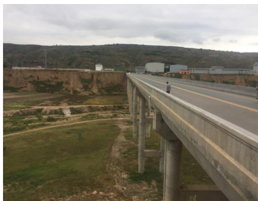
跨河桥梁两侧采取设防撞栏，设置事故废水排放系统
