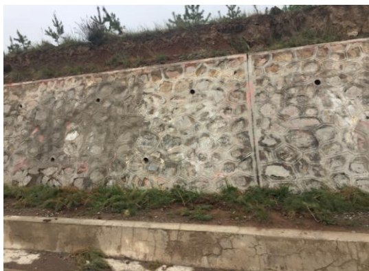
六棱混凝土预制空心块+植草护坡
